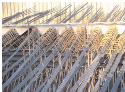
Abb. 4: Verankerung der hyperbolischen Spannglieder
