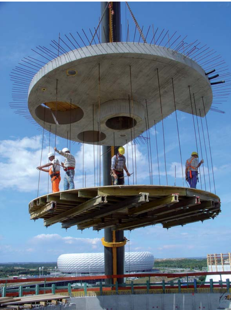
Abb. 16: Hyperbolische Vorspannung
