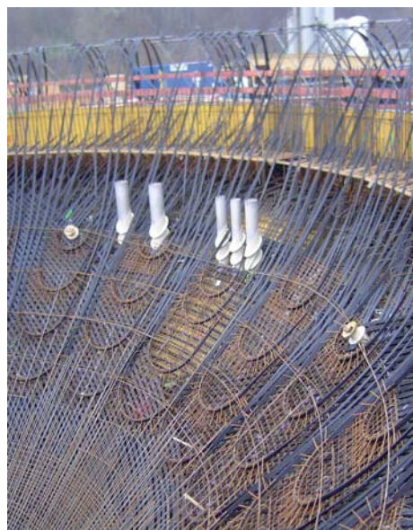
Abb. 5: Vertikale Vorspannung
