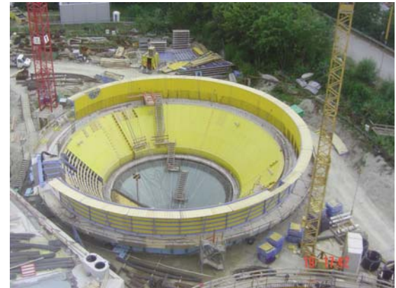
Abb. 11: Außenschalung Trichterspitze
