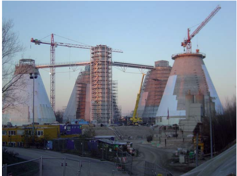
Abb. 14: Aufbringen der Außendämmung
