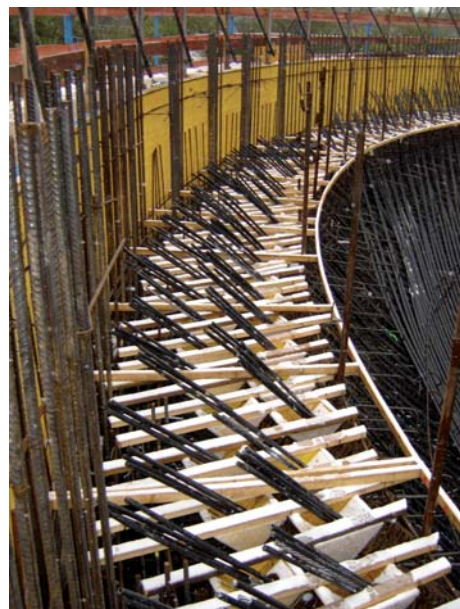
Abb. 3: Verankerung der Spannnischen
