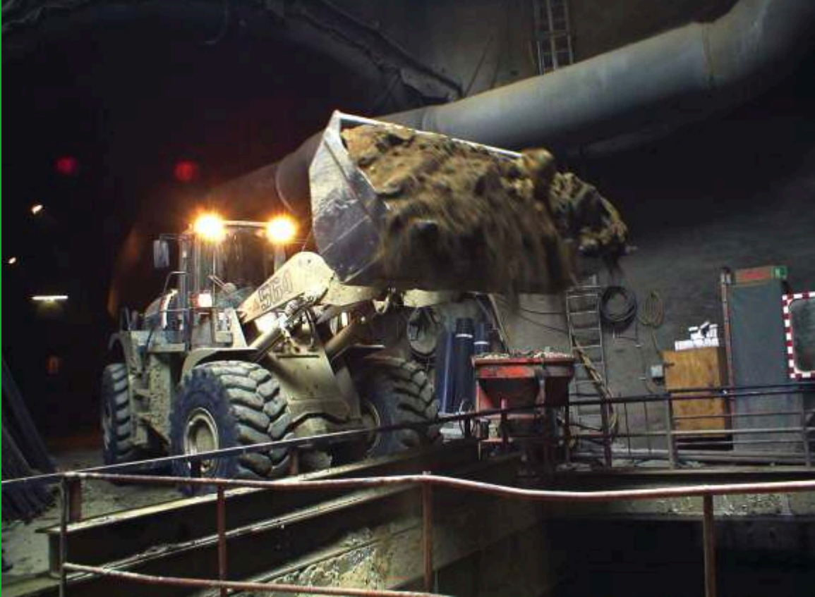
Radlader beim Schüttern im Startschacht
