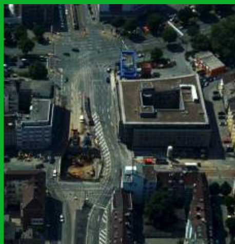
Baugrube Hamburger Straße
