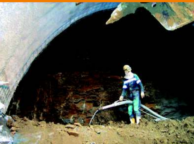
Fertig zum Trockenspritzen
