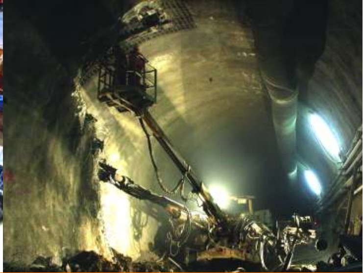
Herstellen der Außenschale
